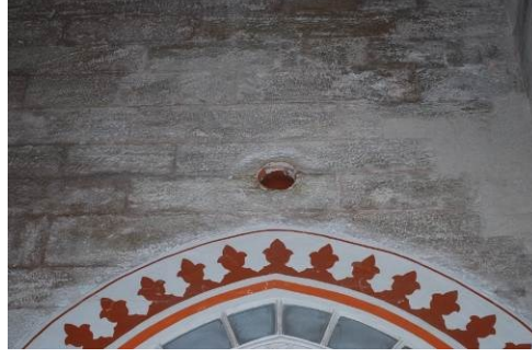
Resim 4. İstanbul Şehzade Cami Yan Duvarlarda açıklıklar (Boşluklu rezonatör-sesin enerjisinin düşürülmesi için kullanılmıştır 2013).
