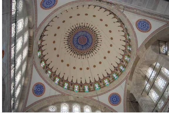
Resim 1. Edirnekapı Mihrimah Sultan Cami Kubbe ile Küp formu geçiş Pandantifler (Yansıtıcı yüzeyler olarak kullanılmıştır 2013).
