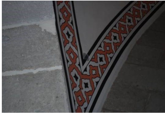
Resim 3. Edirnekapı Mihrimah Sultan Cami Kubbe ile Küp formu geçiş Pandantifler (Boşluklu rezonatör-sesin enerjisinin düşürülmesi için kullanılmıştır 2013).
