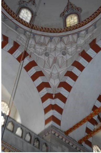
Resim 2. İstanbul Şehzade Cami Kubbe ile Küp formu geçiş Mukarnas (Sesin saçıcı' lığı için kullanılmıştır 2013).
